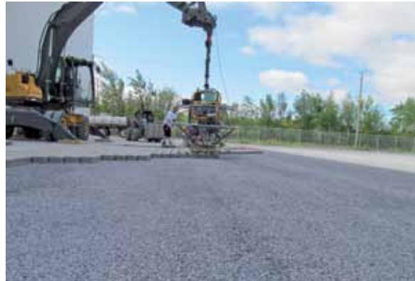
Comme il s'agit de grandes surfaces, l'équipe a également mis au point un appareil mécanisé, breveté qui facilite et accélère la pose des pavés, une fois la fondation complétée. Cette innovation réduit les coûts d'installation.
