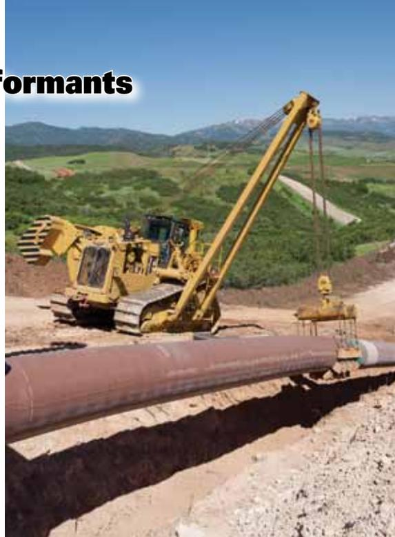
batteries spéciaux garantissant des performances optimales de pose de canalisations dans les environnements froids.
