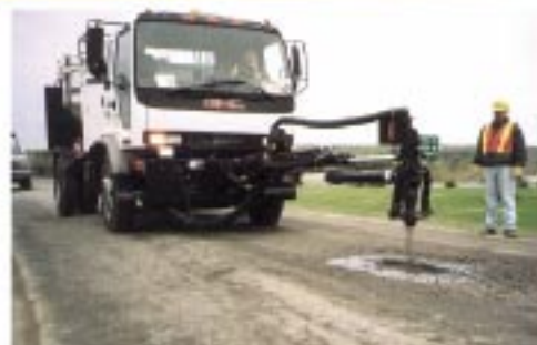
Colmateuse de nids de poule RA300 SprayPatcher La méthode la plus efficace pour des rapiécages durables
