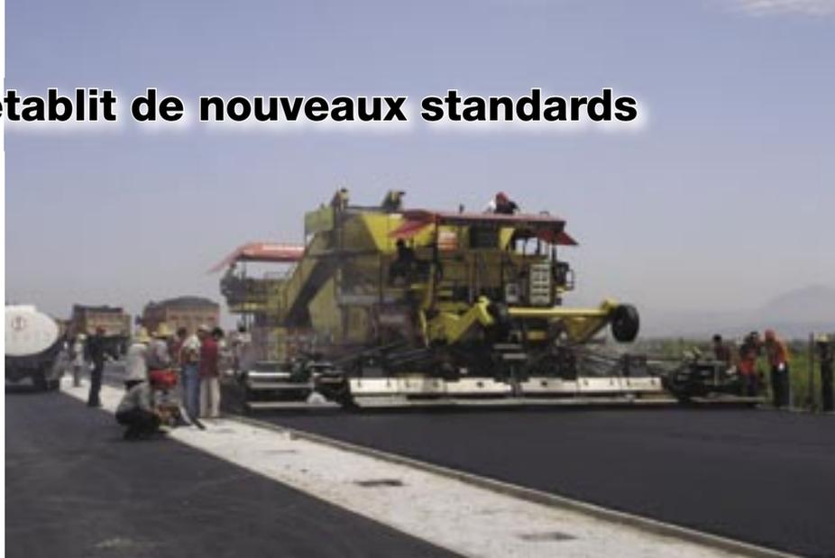
Le système est composé d'un module AM300 qui contient le mélange de la couche de roulement. Il est monté sur une paveuse F300CS, tout comme la seconde table.
