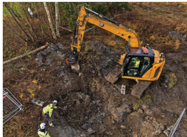
d'une 2<sup>e</sup> ligne hydraulique augmente le débit et la pression hydrauliques à 250 l/min à 350 bar.
