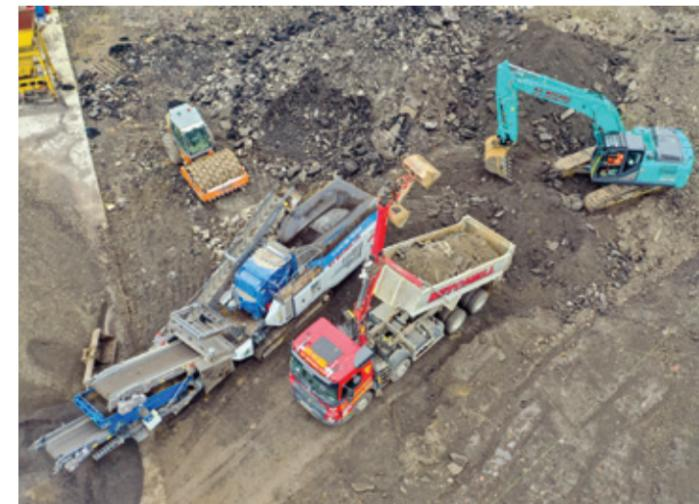
et criblés d'une granulométrie inférieure à 40 mm. Les différentes tailles de particules garantissent un compactage facile du matériau, afin de créer une sous-couche robuste avec une excellente capacité utile. Par ailleurs, le matériau recyclé peut être traité dans l'installation de lavage. En outre, le nouveau concasseur à percussion génère des granulométries d'asphalte inférieures à 20 mm pour alimenter la centrale d'enrobage Ciber.
