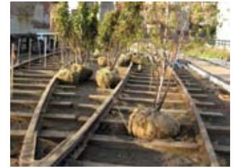
Les travaux de réhabilitation ont débuté en 2006. On a dû retirer tous les rails, le ballast et une couche de béton afin d'inspecter et réparer la structure d'acier.
