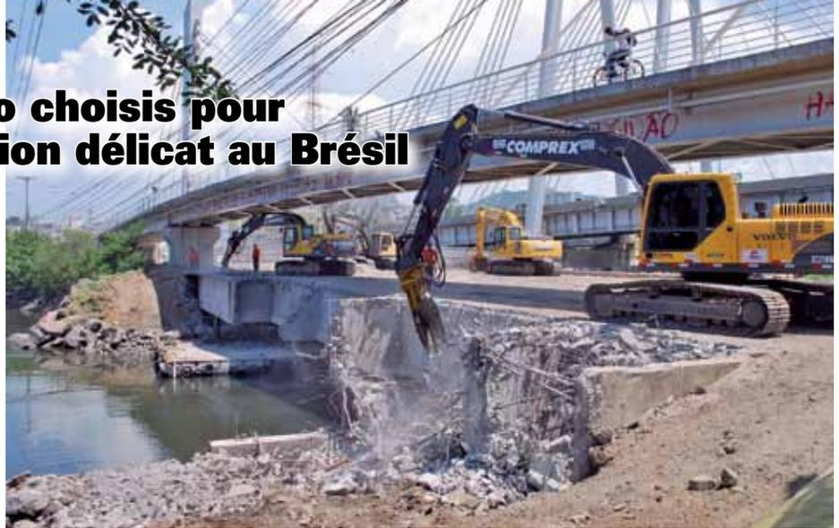
structures légères telles que le parapet, le revêtement en béton, etc. Pour ce faire, l'entreprise a utilisé un marteau hydraulique SB 452 d'Atlas Copco. Une fois cette tâche accomplie, il fallait procéder au travail le plus lourd, c'est-à-dire l'élimination des couches de béton recouvrant les poutres et ensuite les 10 poutres elles-mêmes.
