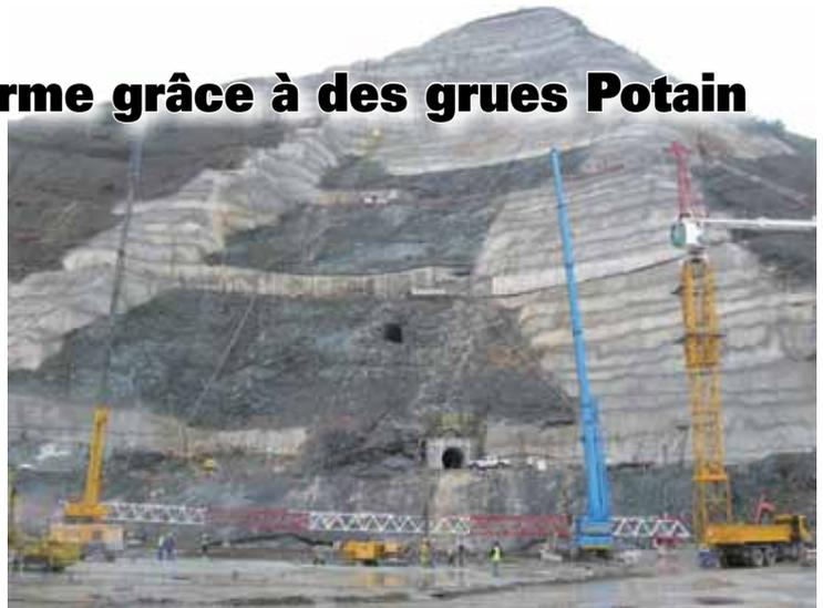
l'histoire du pays. En tout, 1 million m<sup>3</sup> de béton qui seront utilisés pour le barrage, construit à partir de béton compacté au rouleau. Une fois terminé, le barrage mesurera 120 m de haut et 400 m de long, et son épaisseur ira de 100 m au niveau du sol à 8 m au sommet. Sa construction prendra 45 mois.
