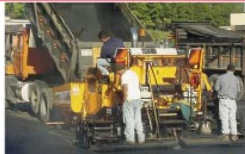
LeeBoy 8515 fonctionne en mode High ou Low Deck, table Legend™ 8 à 15 pi, deux convoyeurs de 36 po. Vts d'alimentation de 12 po. Disponible avec table chauffée électriquement et «Power Slope» sur les extensions
