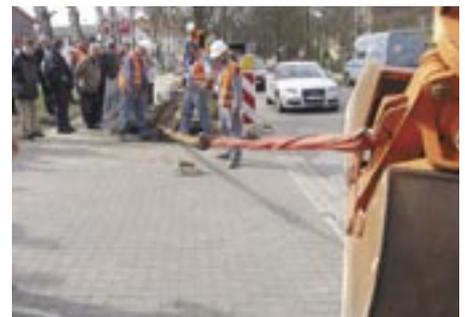
de leurs lignes même si celles-ci ne sont plus exploitées. Une autre raison pour l'enlèvement des lignes peut être le remplacement des anciens câbles, notamment les câbles dotés de fils en cuivre.
