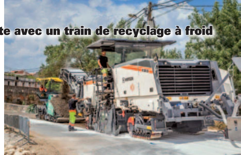
7 kg/m<sup>2</sup> de chaux carré était prévue. Celle-ci a été déposée directement sur l'ancienne chaussée, avant d'être mélangée aux autres matériaux.
