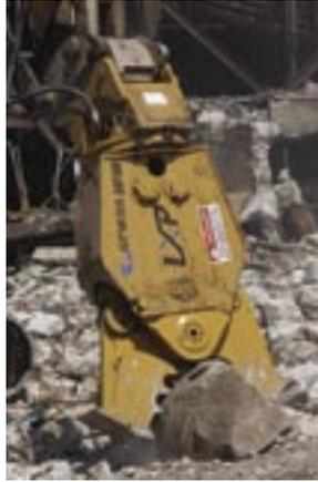
gros blocs, et des mâchoires à pulvériser, pour réduire le béton en morceau plus petits.
