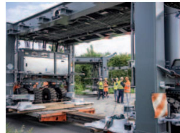
le chantier s'effectue sur la voie logistique parallèle à l'ASTRA Bridge. Une fois les travaux achevés sous le pont, on peut le déplacer jusqu'au tronçon suivant.
