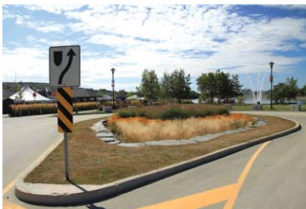
Figure 3 Bassin de rétention végétalisé à Sherbrooke
