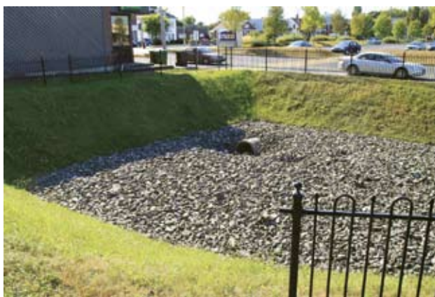
Figure 2 Bassin de rétention à Drummonville
