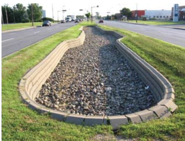
Figure 4 Bassin de rétention à Saint-Laurent
