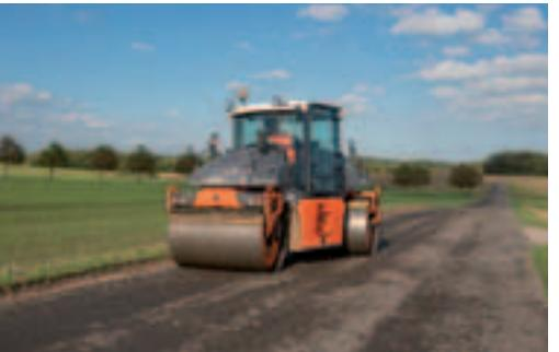
opération sur une largeur de 5,5 m et une épaisseur de 12 cm. Le train de recyclage à froid a évolué à une vitesse de 4 m/min sur la route longue de 3 km. Derrière, les rouleaux Hamm ont effectué le compactage final, la circulation a pu être rouverte
